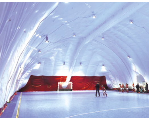
De WMHC hockeyhal in Wageningen. Door de draaideur (midden) is er geen drukverlies in de hal bij binnenkomst.
