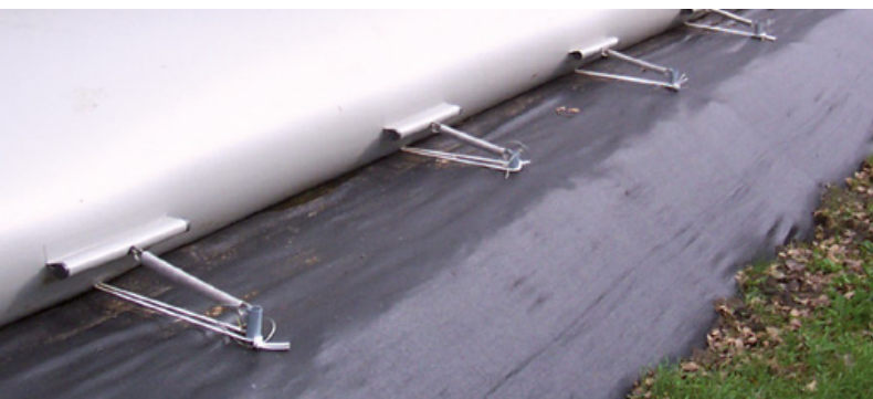
Flexible au sol permet un positionnement correct pour tous les niveaux de liquide.
